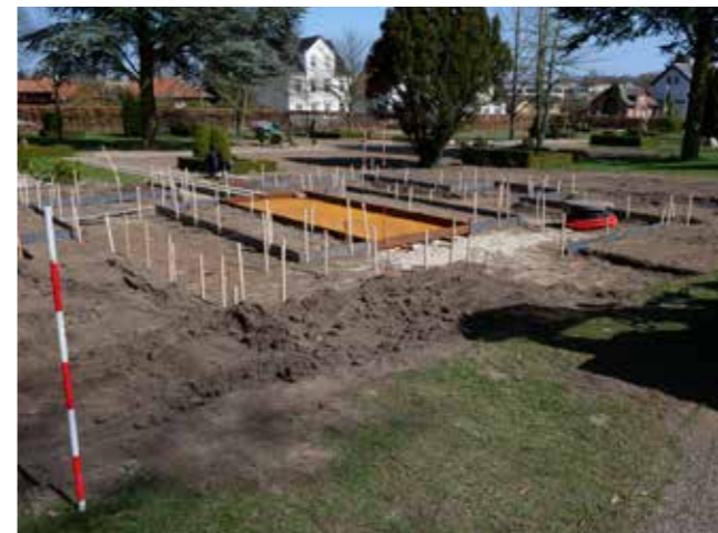
Stålkanter til adskillelse af bede og gange svejses på stedet. Der bruges 6 mm fladstål i 15 cm bredde, som holdes på plads af spyd i T-stål.
